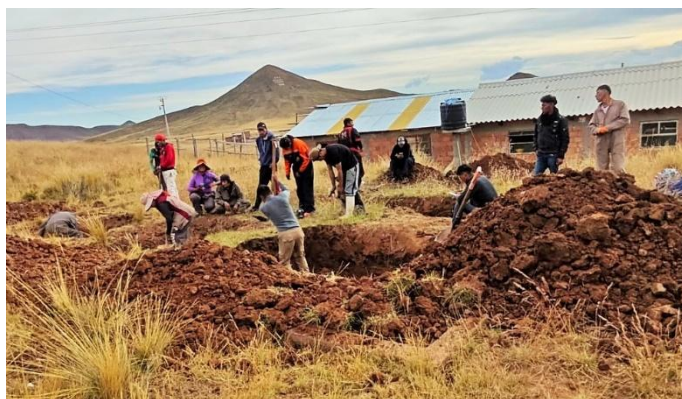
SIAB creusement de walipini (serres semi-enterrées)
